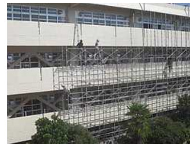
足場を外しています。 パイプを上から下へ。
